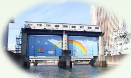
高浜水門(ローラーゲート式)
