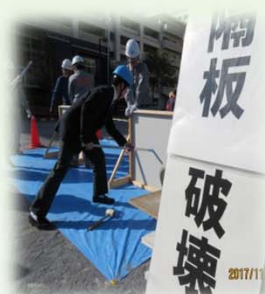
隔壁破壊訓練
