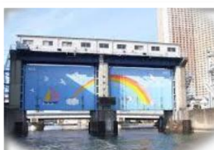
高浜水門や天王洲水門は ローラーゲート式
